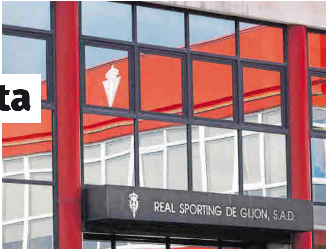
Vidrieras de las oficinas de Mareo antes de la última reforma en la Escuela.
